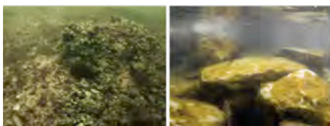
Sehr dicht mit Dreissena besiedelte Sohle Blockwurf am Ufer
