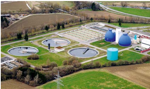
Die Ravensburger Großkläranlage Langwiese besitzt seit 2013 neben den herkömmlich drei Klärstufen und einer Anlage zur Energiegewinnung aus Klärschlamm seit 2013 eine vierte Klärstufe mit Aktivkohle-Filterung. Damit kann sie dem konventionell vorgereinigten Abwasser noch einmal über 90 % der verbliebenen Mikroverunreinigungen entziehen.
